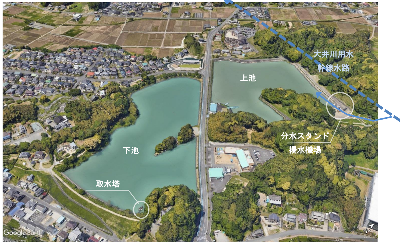
(4)大池 （掛川市大池 1747 年以前建設）
