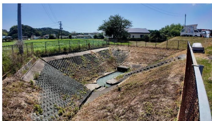
水路起点部（菊川市東横地）
