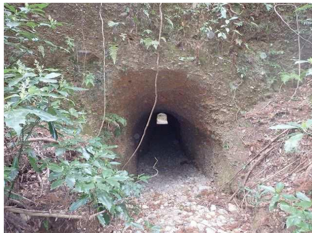
池左岸にある上流側隧道入口
