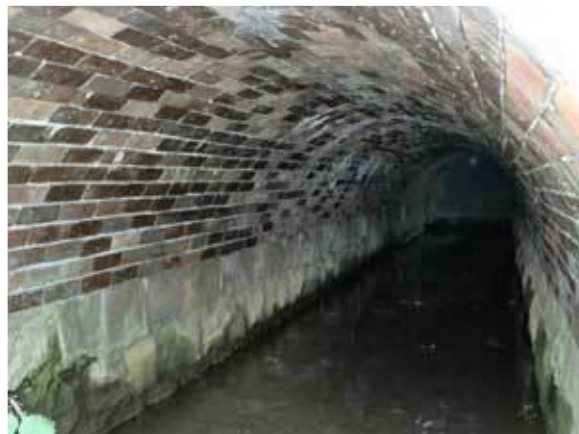
水路トンネル（JR 東海道線線路下）
