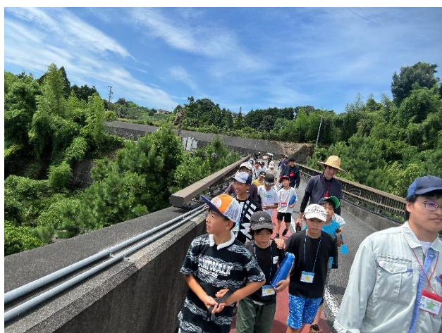
大井川水路橋
