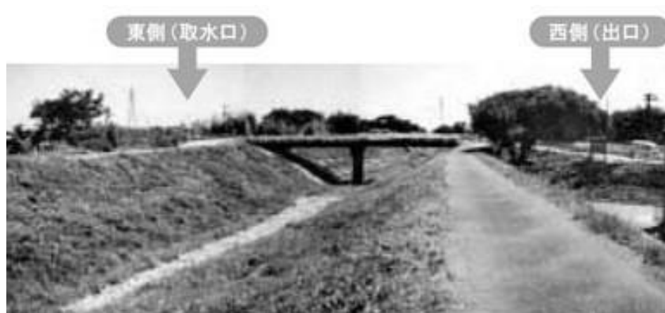
普段は水のない西大谷川の高い堤防を切り割る作られた十内坎
