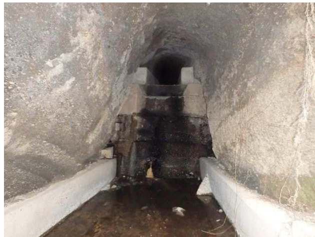
下流側隧道出口
