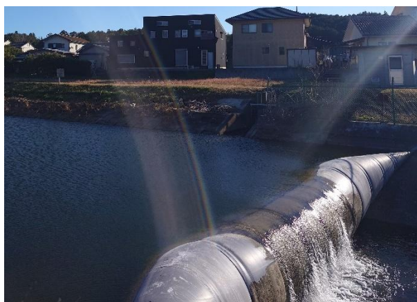
倉真川取水口頭首工
