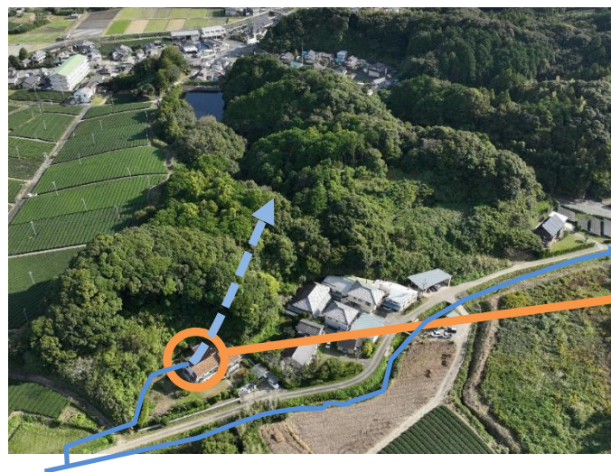
上流のため池の水を導く隧道
