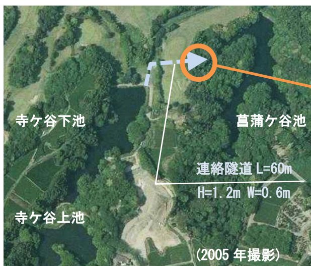
寺ヶ谷下池と菖蒲ヶ谷池の連結 (掛川市)
