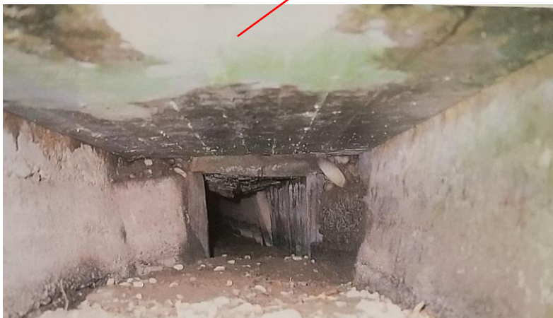
地下水路「十内垵」（掛川市指定文化財）
