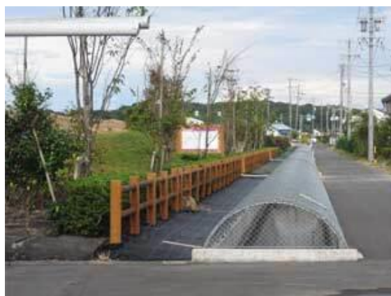
水路（菊川市嶺田 井宮神社前） 水路上部に転落防止ネットフェンス設置
