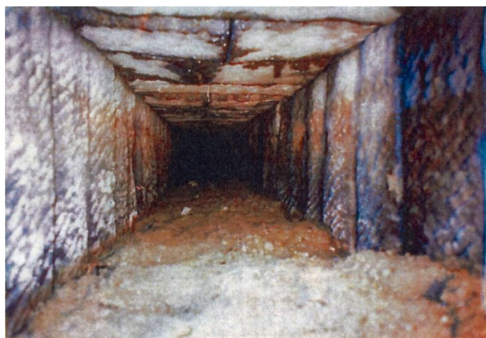
厚 13cm、巾 25cm の石材で作られた 川底の下の地下水路「十内坎」
