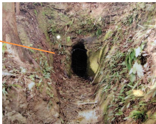
かつての連結隧道 L=100m H=1.2m W=0.6m
